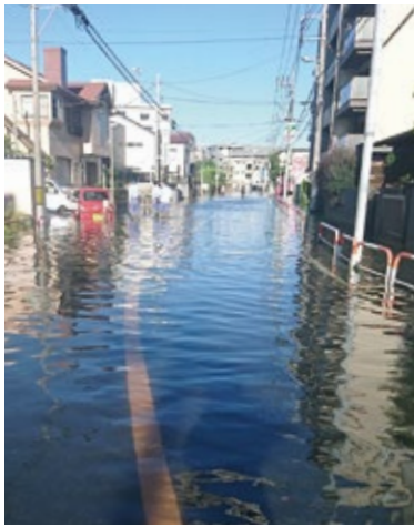
▲冠水した戸田中通り
